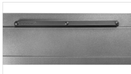
10.) Die Mitteldichtung muss nicht komplett entnommen werden, lediglich die Fahne der Mitteldichtung muss mit einem scharfen Cuttermesser gegenüber des Regel-air® FFL-uni auf Lüfterlänge weggeschnitten werden.
