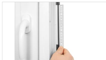
10.) Sollte eine Mitteldichtung vorhanden sein, ist diese direkt gegenüber des Regel-air® FFL-uni zu entfernen.
