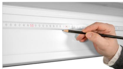
2.) Nun kann die Schablone so zwischen Blendrahmen und Fensterflügel geklemmt werden, dass der mittlere Bohrkanal auf dem Strich liegt. Sollten zwei Lüfter montiert werden, sollte ein Ende der Schablone am Strich anliegen.
