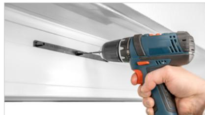
⚠ **Wichtig:** Bei beengtem Bauraum zwischen Flügel und Rollladenkasten/Sturz ist eine Montagehilfe optional bei uns erhältlich, welches das Bohren erleichtert. Alternativ kann auch ein kompakter Akkuschauber verwendet werden.
