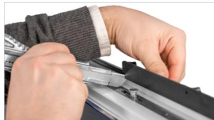
7.) Die Flügeldichtung wird mit einem scharfen Cuttermesser zwischen den eingeschnittenen Dichtungen weggeschnitten oder komplett entfernt.
