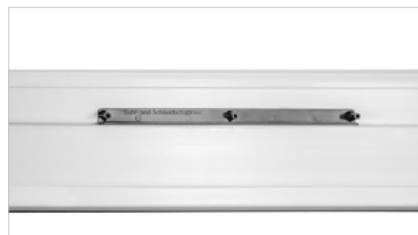
3.) Die Schablone sollte vor dem Bohren nochmals auf den Fensterflügel aufgedrückt werden. Nun wird mit einem 3mm-Bohrer durch die Bohrkanäle vorgebohrt.
