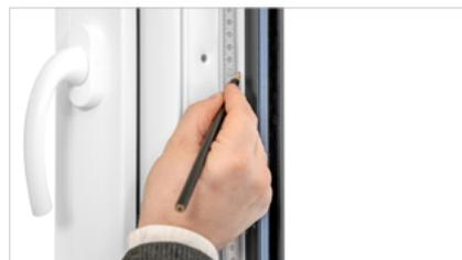
9.) Nun wird mittig im senkrechten Bereich, rechts und links je 150 mm Dichtung weggeschnitten oder komplett entfernt. Werden zwei Lüfter montiert, wird pro Seite 300 mm Dichtung entfernt. Für die Variante „Hohe Volumenströme“ wird die Dichtung direkt oben waagrecht gegenüber der Lüfter auf 300 mm bzw. 600 mm entfernt.
