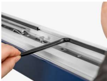
Entnahme der Flügeldichtung
