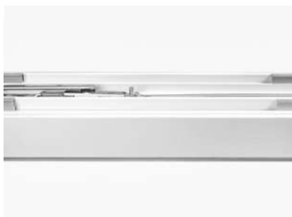
Entnahmen der Dichtung bei einem Holzfenster
