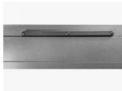
Montierter Lüfter bei einem Aluminiumfenster
