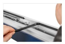
Entnahme der Flügeldichtung
