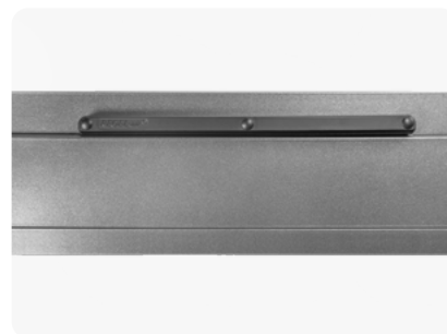
Montierter Lüfter bei einem Aluminiumfenster
